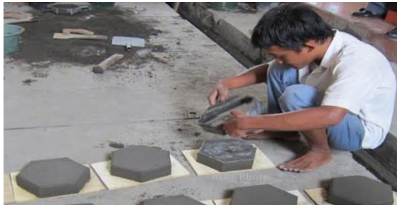
Gambar 2.2. Cara membuat paving block manual Sumber:
